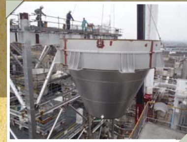
ボイラ用ミル更新工事バンカー鉄骨①
