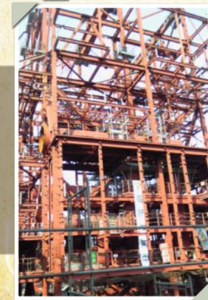
副生ガス焚きボイラ設備ボイラ鉄骨①
