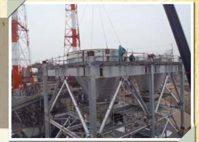
ボイラ用ミル更新工事バンカー鉄骨②
