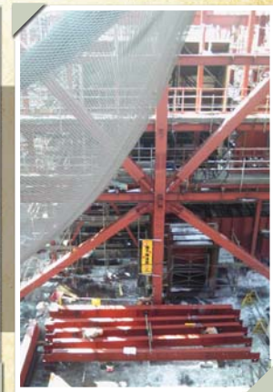
副生ガス焚きボイラ設備ボイラ鉄骨②
